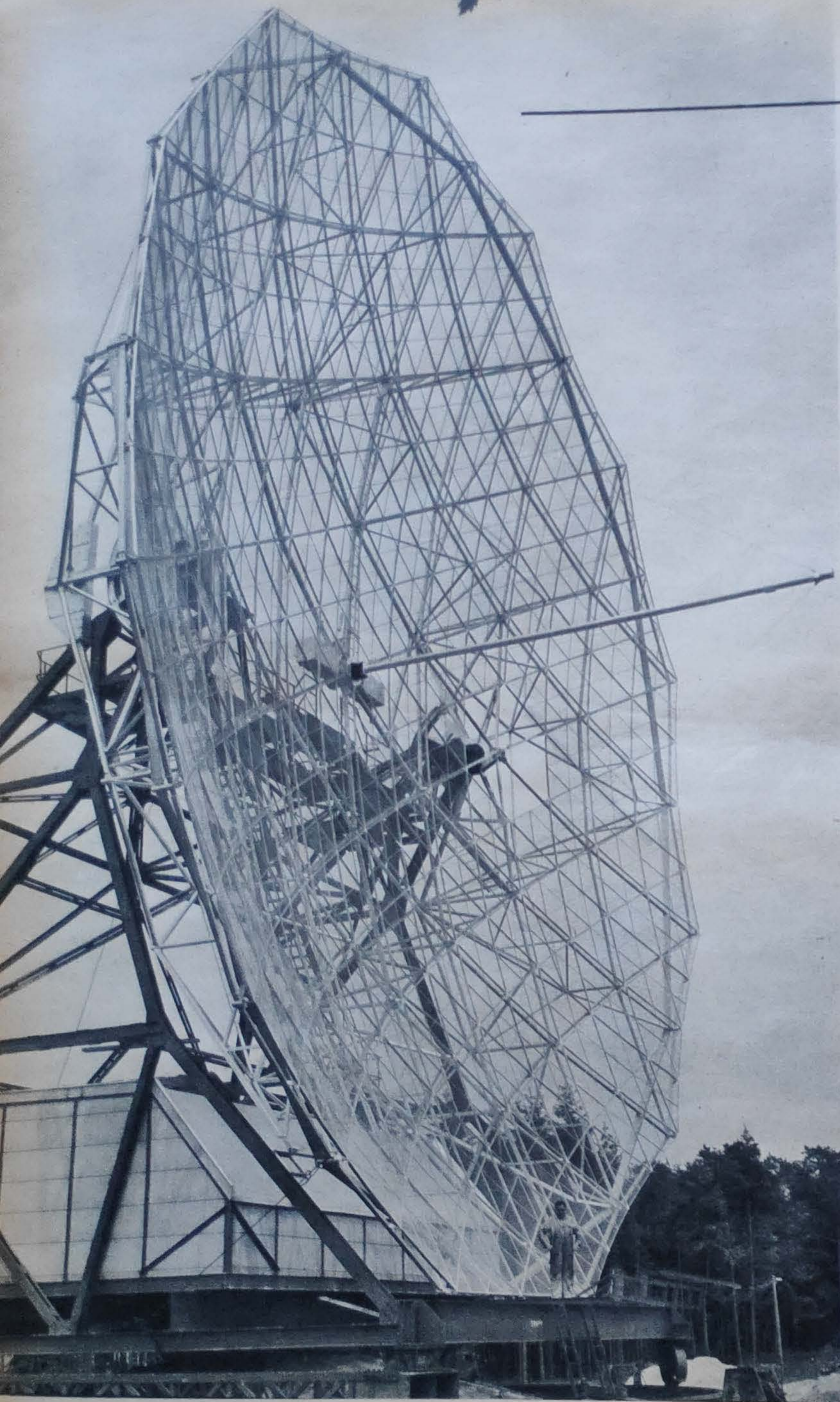
FOTO LINKS: Op een zwaarbetonnen voetstuk staat de toren, die de machtige holle, draaibare telescoopspiegel met een middellijn van vijftien meter draagt. De staaf in het midden is de antenne, die de naar het brandpunt van de spiegel teruggekaatste radiogolven uit het heelal oprvangt. Deze worden naar het bedieningshuis, onder links op de foto, geleid, waar ze versterkt en geregistreerd worden.
