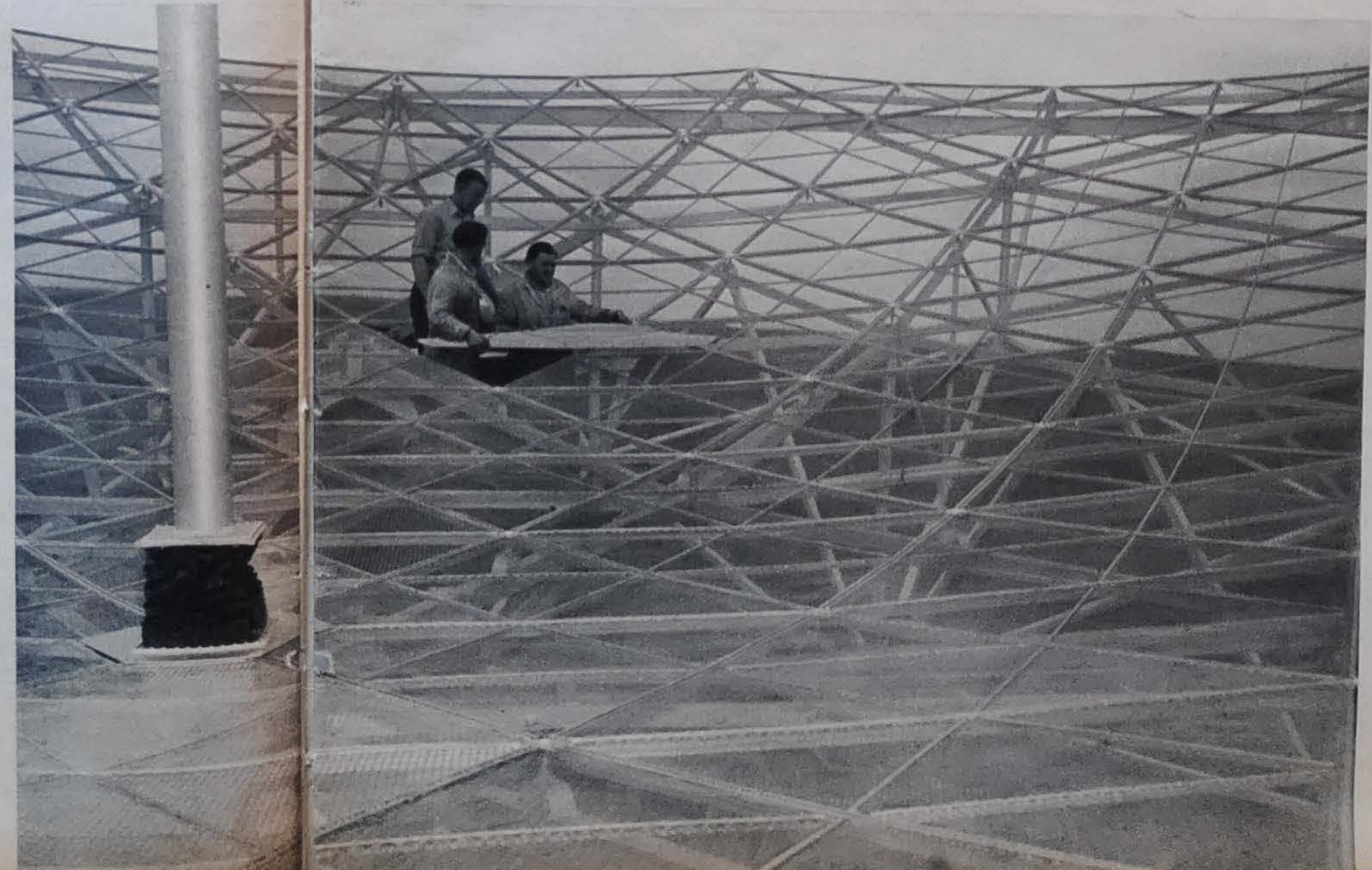
FOTO ONDER: Een wonderlijk soort spiegel, niet van glas, maar uit metaalgaas geconstrueerd. De lichtgolven laat het gaas door, maar de veel grotere radiogolven worden er door tegengehouden. Zoals water wel, maar stroop niet door een fijne zeef heen loopt. De spiegel is opgebouwd uit honderden met metaalgaas bespannen stalen driehoeken.
