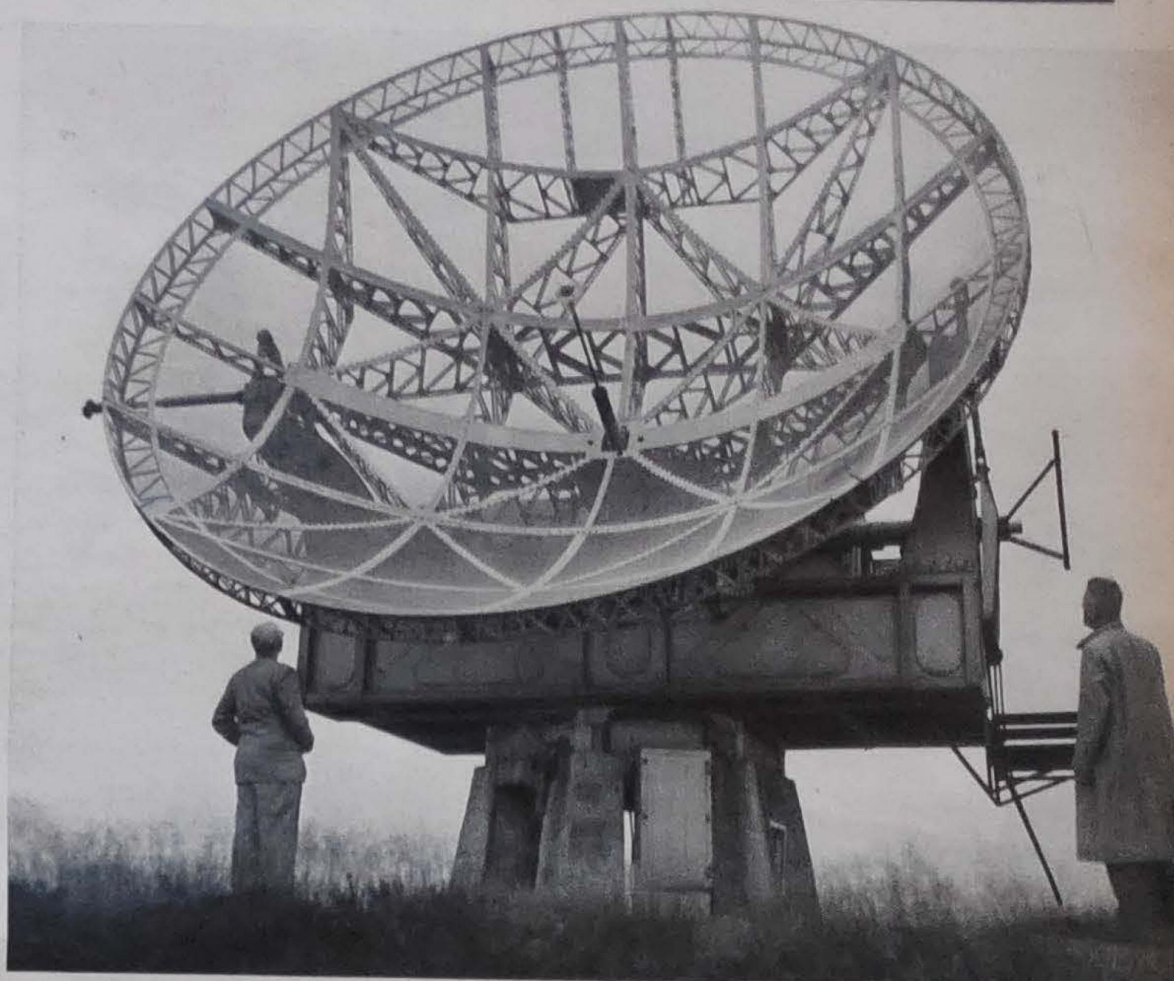
De „Parabool" te Kootwijk, een oude Duitse radar-antenne, verbouwd tot Nederlands eerste radiotelescoop, waarmee op 11 Mei 1951 de waterstofstraling uit de Melkweg werd opgevangen. Deze geïmproviseerde radiotelescoop heeft een middellijn van zeven en een halve meter.
